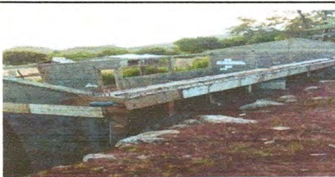
Foto 3: Mantenimiento de la estructura de láminas
