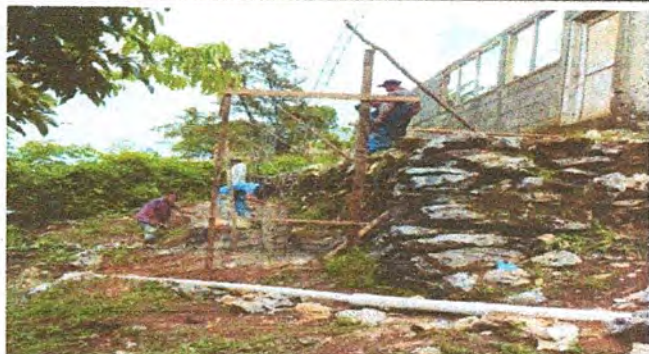
Foto1: Inicio de muro
