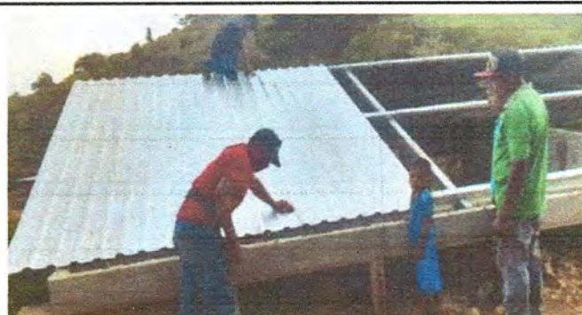
Foto 4: Mantenimiento de la estructura de láminas
